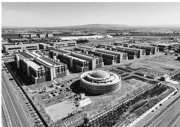
阿里巴巴(乌兰察布)数据中心。(段建宁/摄) 借势:从“天然冷”到“智算热”
